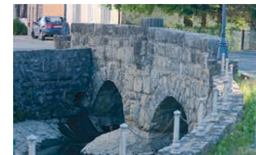
Kamenný most přes Gate – Jaruge postaven roku 1801
